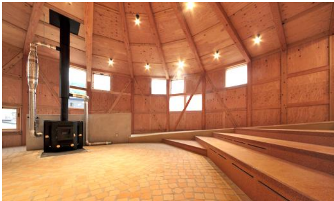
薪ストーブの煙突熱を利用した熱循環装置
