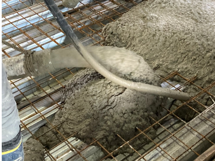
▲コンクリート打設状況
