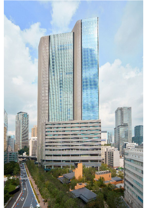
『赤坂インターシティ AIR』外観
