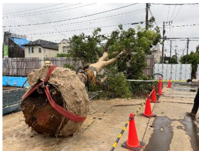
ヤマモモの移植工事の様子
