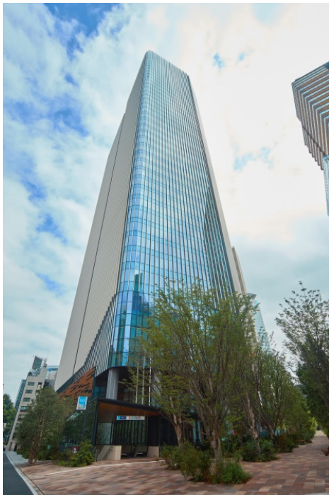
▲赤坂インターシティ AIR 外観
