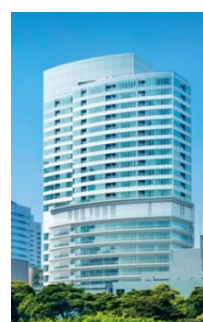
浜離宮インターシティ
