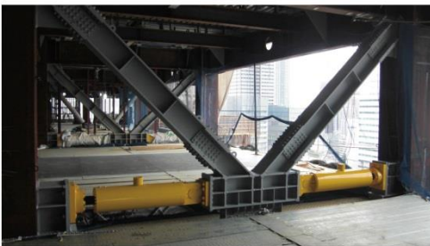
アンボンドブレース Buckling restrained brace (unbonded brace)
