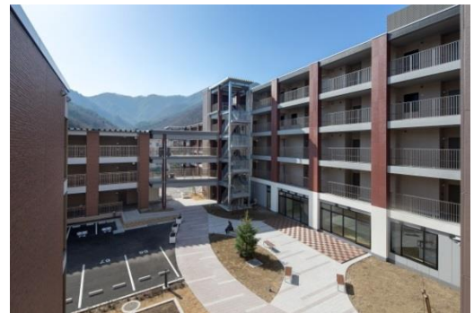
「釜石市上中島町復興公営住宅第Ⅱ期」外観写真
