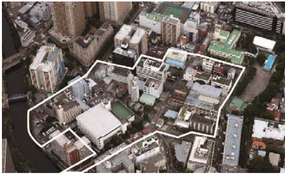
2011年撮影(既存建物解体前)
