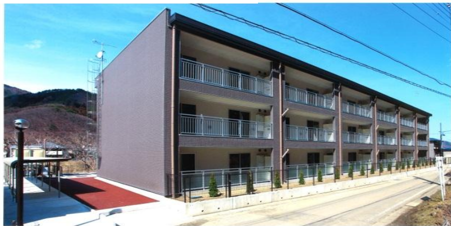
※日鉄物流釜石(株)の社宅(18戸)、H24.3竣工
