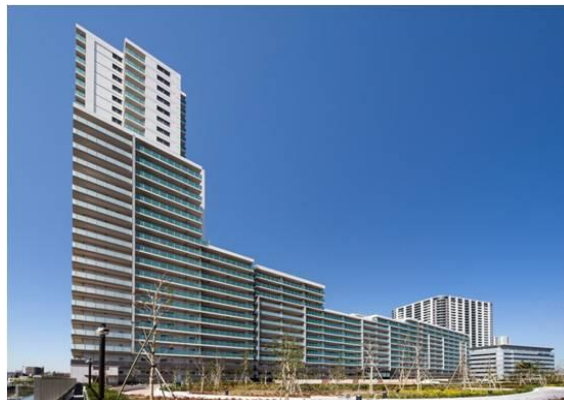
〈全体外観写真〉
