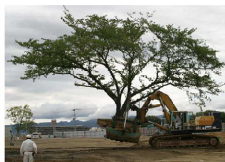
重機を使ったサクラの移植状況
