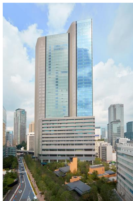
『赤坂インターシティ AIR』外観
